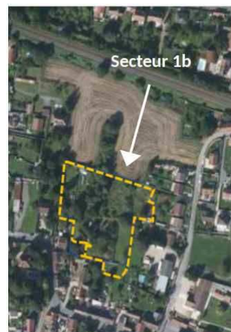
Figure 11: Limite approximative du secteur 1b de l'OAP centre bourg, MRaE sur photo aérienne Géoportail (2021)
